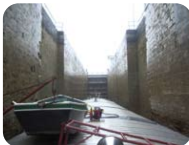
Ecluse sur Canal du Nord - Source : Florence LHOPITAL- Batelière
